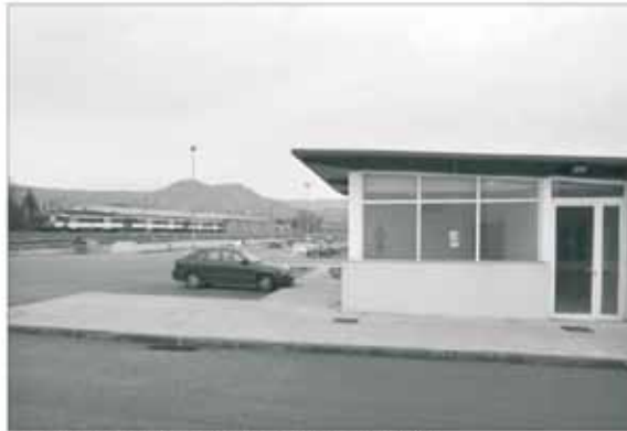
Aquest és l'edifici, acabat, però tancat i barcat, de l'estació de mercaderies de Vic.
